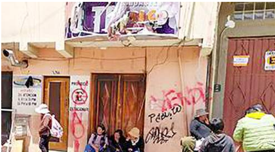
IMAGEN 74. FACHADA DE LA RADIO MEGA EN ORURO DESTRUIDA
